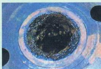
97.105 開放点検時 (約3ヶ月後)
