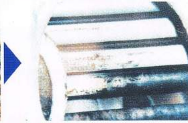
設置後3ヶ月、チューブのスケールは、きれいになっている。
